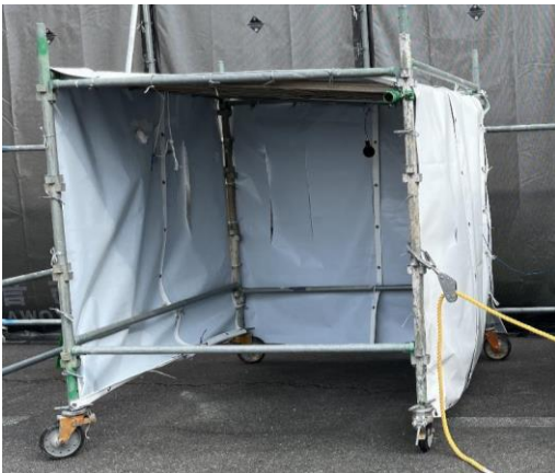
図 4. 「涼し〜ト(TM)」施工の簡易休憩所
